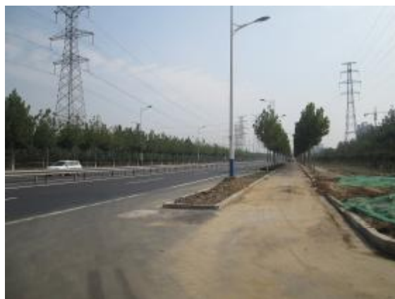
项目北侧现状（北疏港路）
