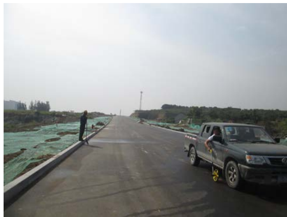
项目西侧现状（大山西路）
