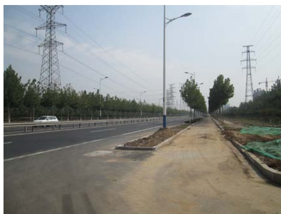
项目北侧现状（北疏港路）
