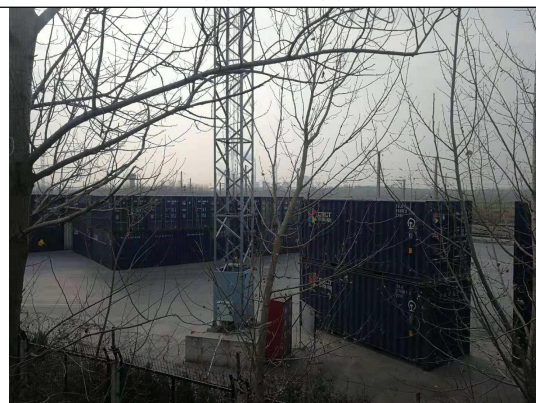
项目西侧——坪上站货运区
